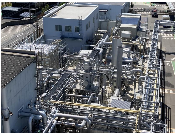
フタムラ化学（株）大垣工場 ガスタービンコージェネレーションシステム
